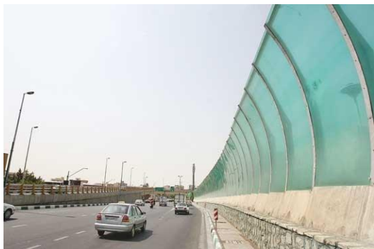
شکل ۱. دیوارهای صوتی استفاده شده در بزرگراه‌های شهر تهران
